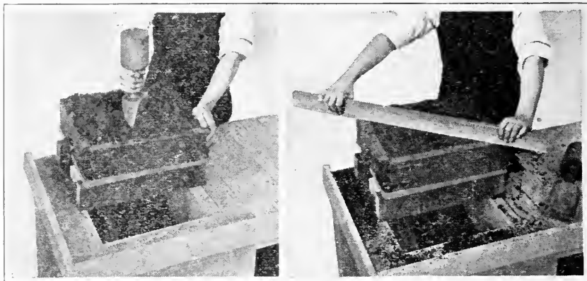
FIG. 500. RAMMING THE DRAG.
